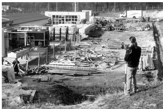
Építés-felügyelet (Fotó: Busics György)
