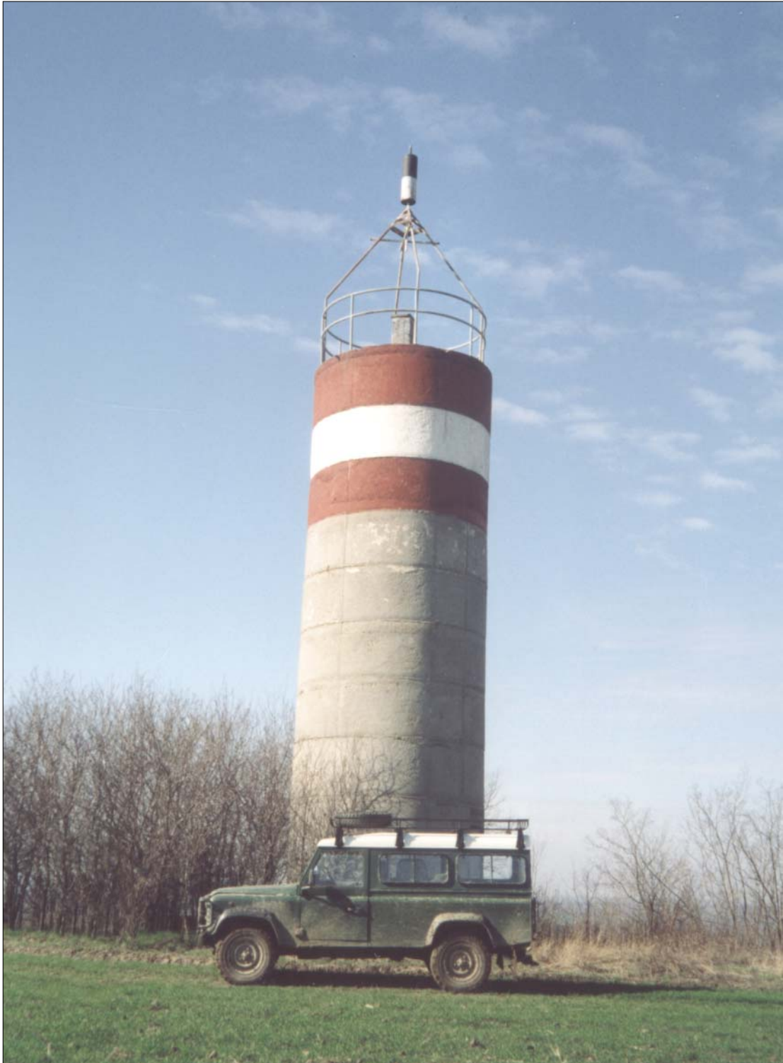
A felsőrendű vízszintes alaphálózatban létesített vasbeton mérőtorony (Fotó: ... Nándor)
