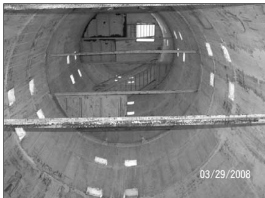
Mérőtorony belseje: a vaslétrák hiányoznak (fotó: Palló Gábor)
