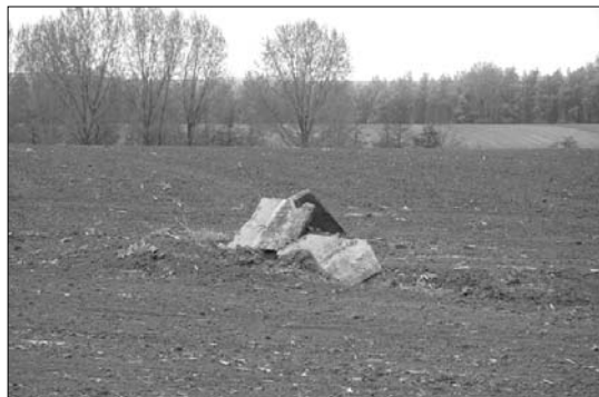
2. ábra Szétdőlt vasbetonlapos védmű (fotó: HBA)
